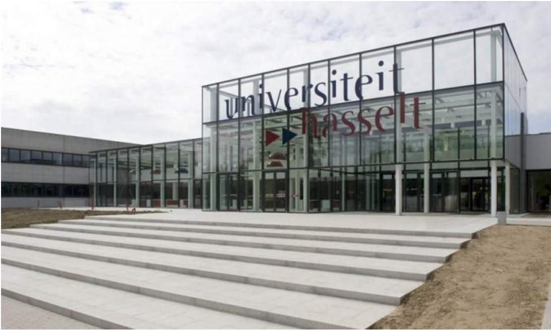
Kuva 2. Hasseltin yliopiston päärakennus
